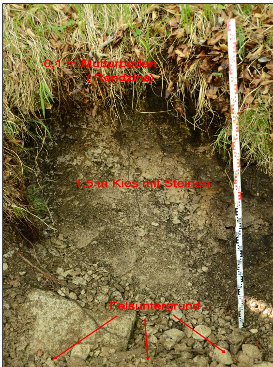
Abbildung 9: Foto Bodenaufschluss Schurf Nr. 4 mit Benennung der angetroffenen Bodenschichten
